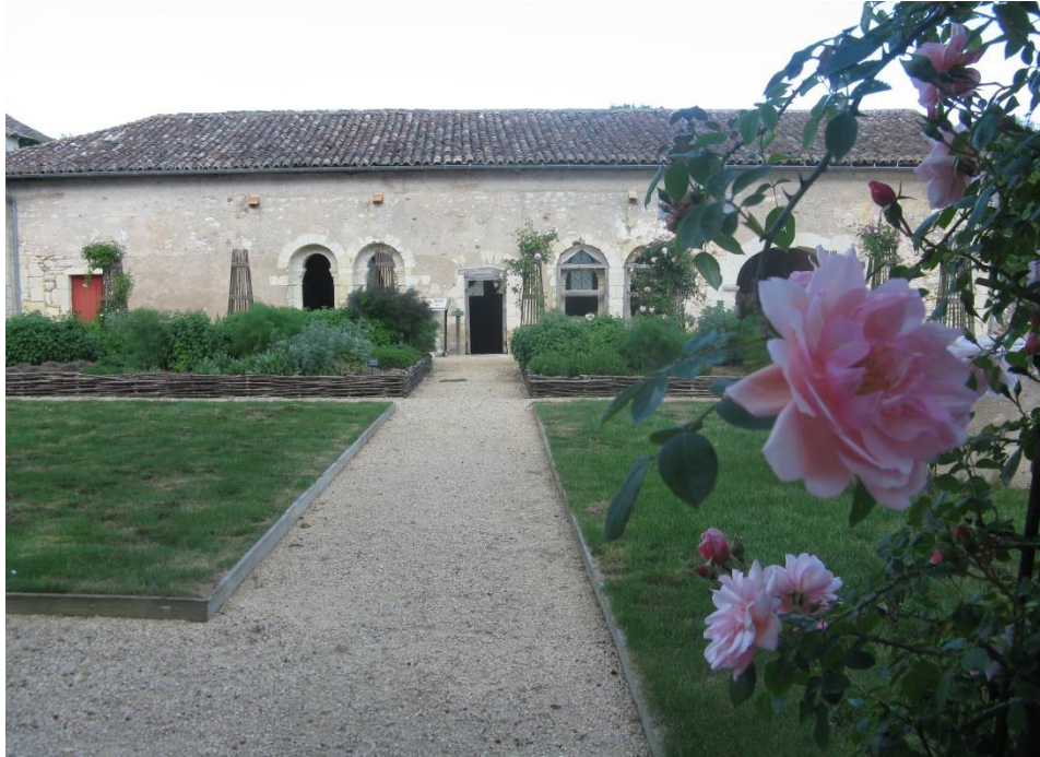
Le bâtiment des moines.
